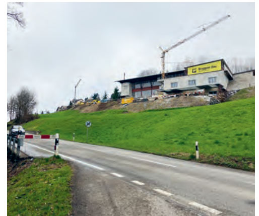
Der Seitenbach des Talbachs entsteht in der Grünau und kreuzt die Kantonsstrasse unterirdisch.
