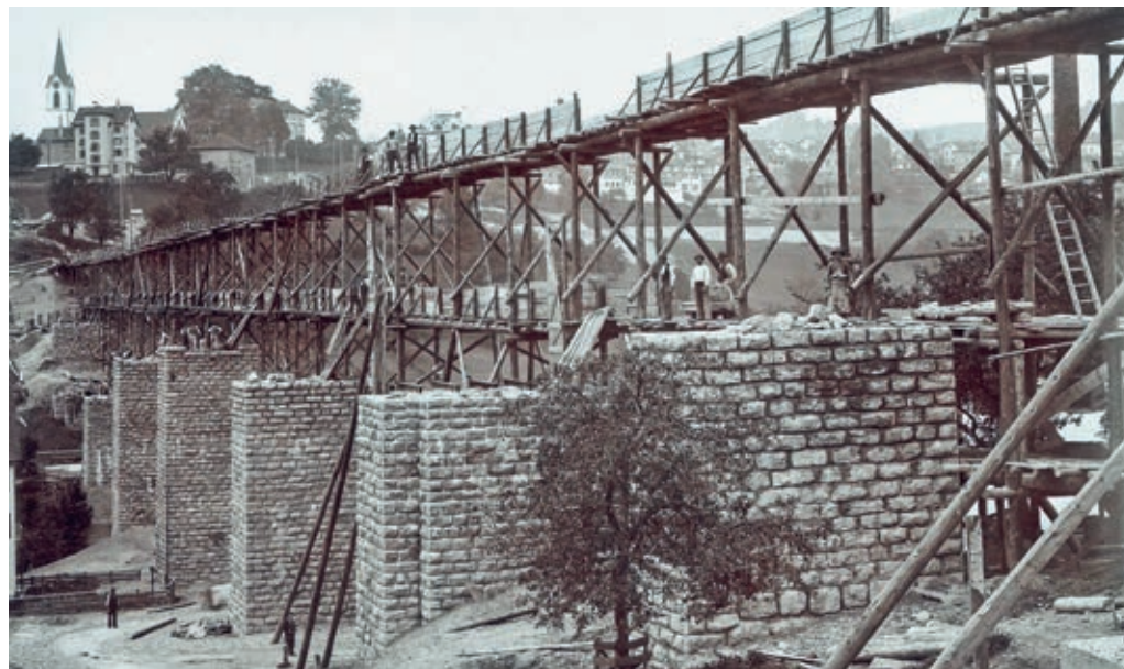
Der Bau der Brücke über die Glatt, 1908. Im Hintergrund ist die katholische Kirche von Herisau zu sehen.
